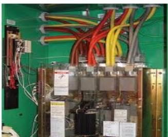
**2) Características de los conductores.** Los conductores en paralelo de cada fase, polaridad, neutro, conductor puesto a tierra del circuito, conductor de puesta a tierra de equipos o puente de unión de equipos, deben cumplir con todas las siguientes condiciones: Tener la misma longitud.
